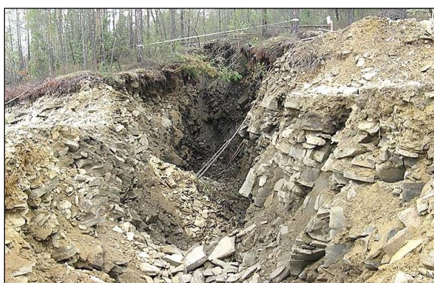
Рис. 2. Фото морщинистого склона [18, рис. 11] и результаты послойного моделирования экскавации системы «выемка–геосреда» с трещинами на поверхности откосов (бортов): 1:m = 1:2 , k_{st} = 0,99 , d = 44,00 м
