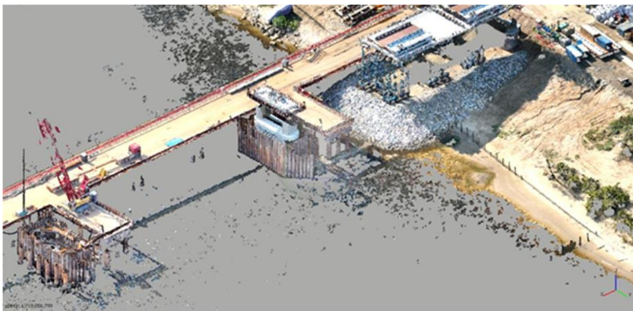
Рис. 3. Текущее содержание искусственных сооружений с помощью беспилотных летательных аппаратов
