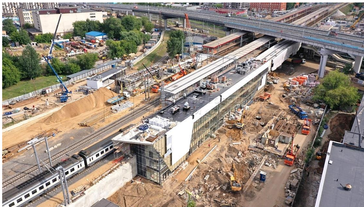
Рис. 1. Пример строительства транспортно-пересадочного узла (ТПУ) в г. Москве
